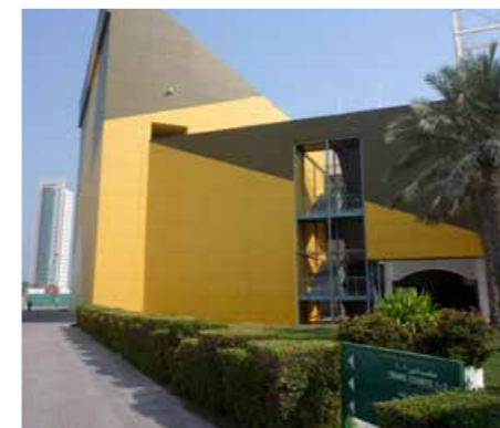
Hinterlüftete Fassade
